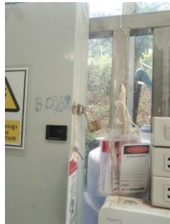
ระบบ Lock Out - Tag Out ตู้ควบคุมไฟ มีการล็อกกุญแจ แขนงป้าย ตามมาตรฐาน
