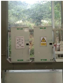
ระบบ Lock Out - Tag Out ตู้ควบคุมไฟ มีการล็อกกุญแจ แขนงป้าย ตามมาตรฐาน
